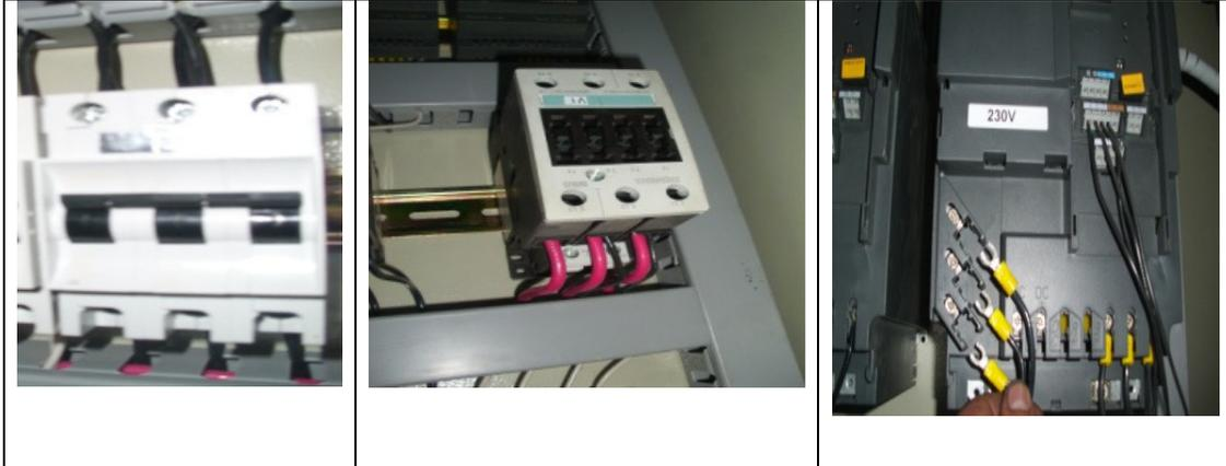
**Figura 7.5 Instalación de sistema de fuerza máquinas de lavado**
