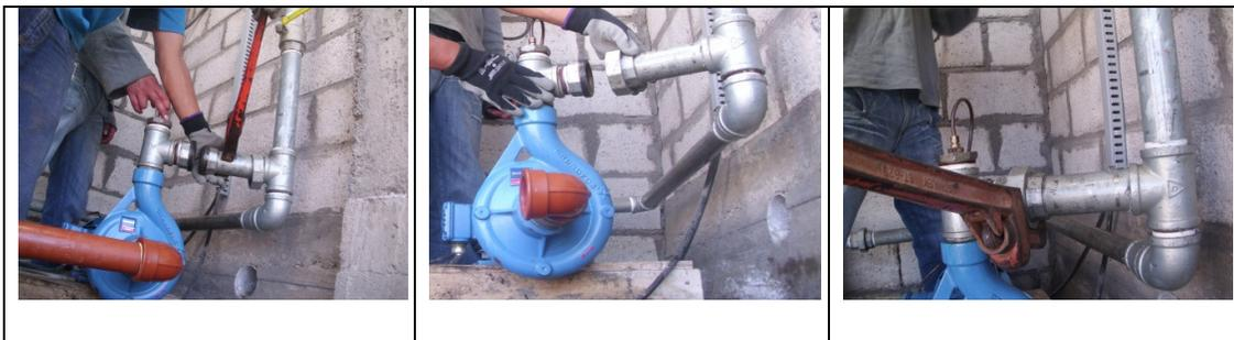
**Figura 8.4 Conexiones de la tubería galvanizada de 2-1/2 pulgadas**
