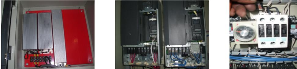
**Figura 7.9 Instalación de fuerza máquina de centrifugado**
