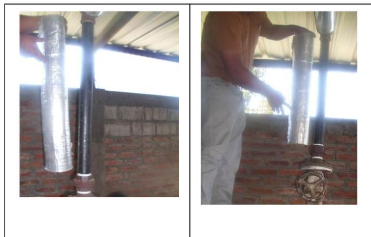
**Figura 8.11 Colocación del aislante térmico**
