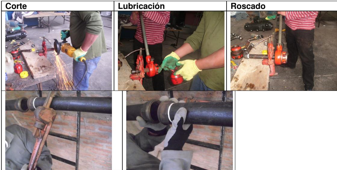
Figura 8.9 Adaptación de la tubería
