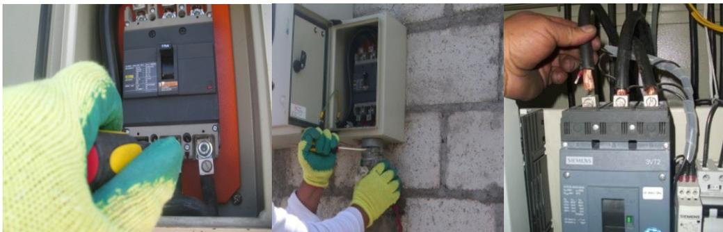
**Figura 7.3 Conexión de la energía al tablero**
