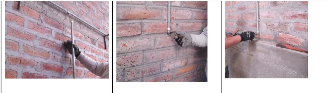
**Figura 8.16 Conexión de la red de aire comprimido**
