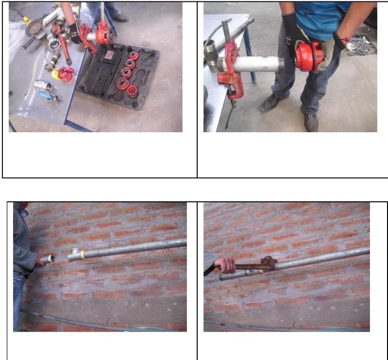
**Figura 8.5** Instalación red hidráulica
