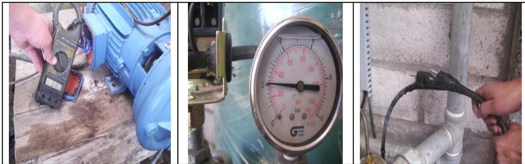
**Figura 9.16 Variables de control bomba de agua**
