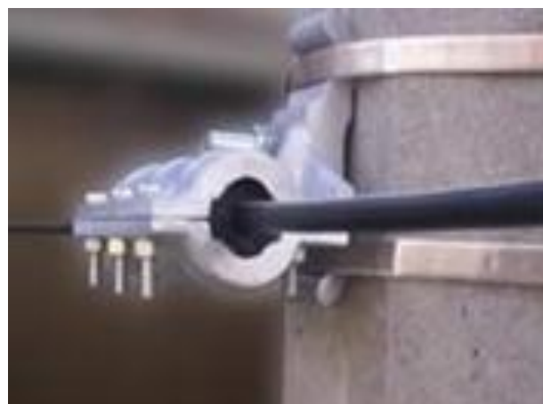
Figura 19. Instalación Herraje tipo B para fibra óptica.
