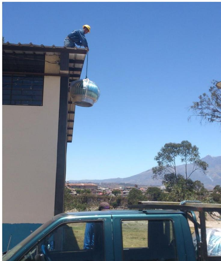
**Figura 69.** Instalación extractor eólico.
