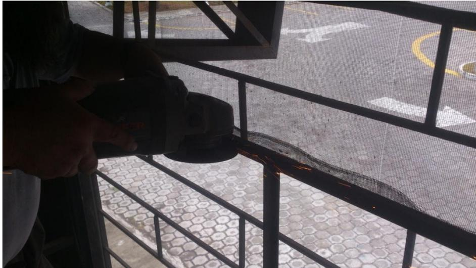
**Figura 27.** Desmontaje de mallas en ventanales.
