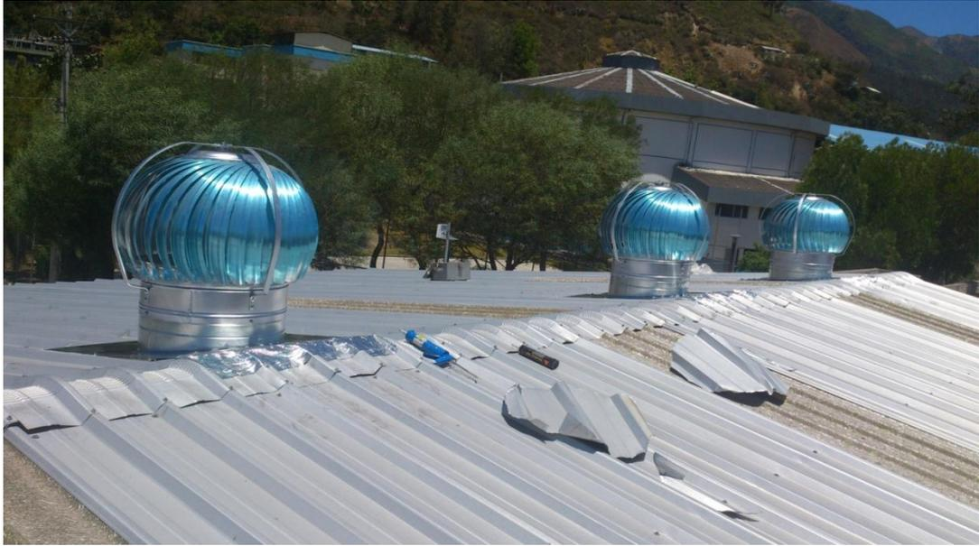
**Figura 86.** Extractores eólicos instalados.
