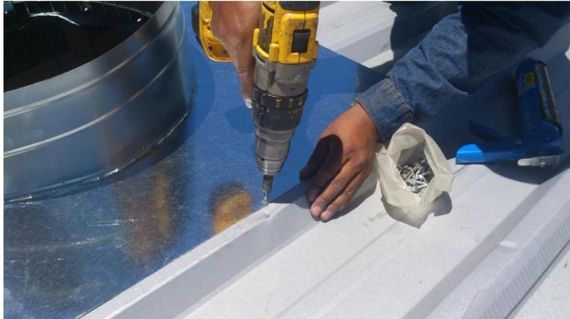
**Figura 72.** Ajuste de base al techo.
