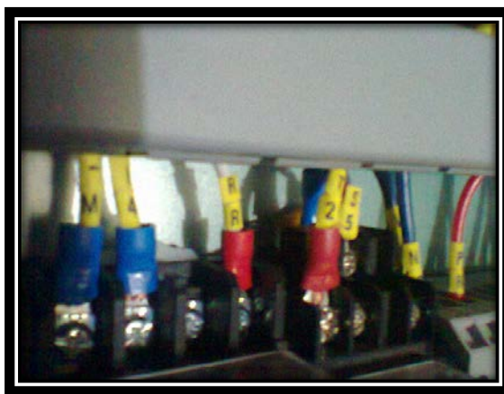
Figura 3-14 Terminales de Conexión en el Módulo
