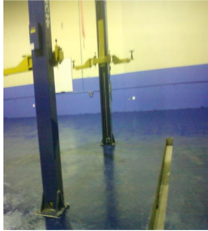
Fotografía N°27. Colocación de la pintura epoxica para piso
