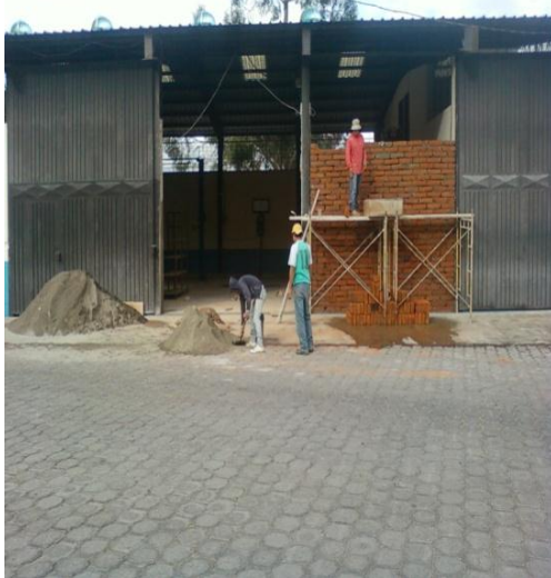
Fotografía N°15. Proceso de reubicación del portón
