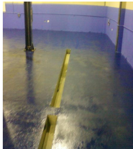
Fotografía N°29. Colocación de la pintura epoxica para piso
