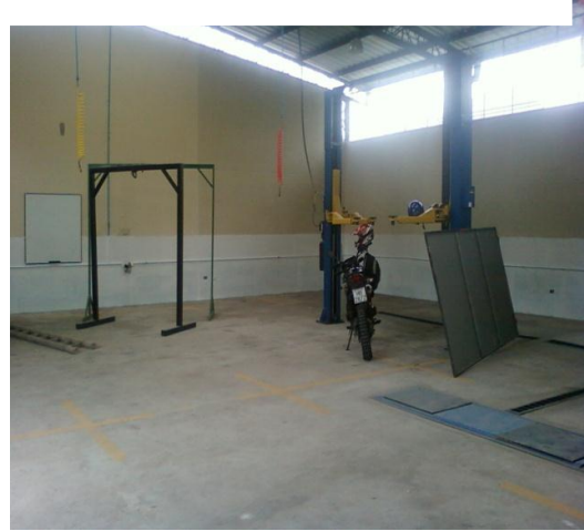
Fotografía N°20. Proceso de pintura en pared
