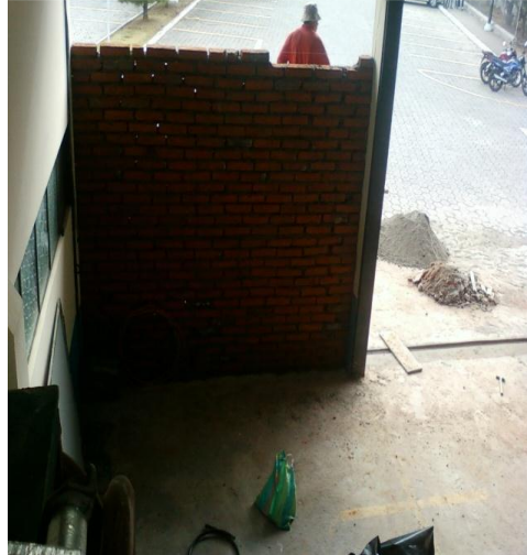
Fotografía N° 16. Proceso de reubicación del portón
