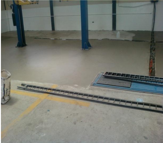
Fotografía N°22. Colocación de la nueva capa de piso
