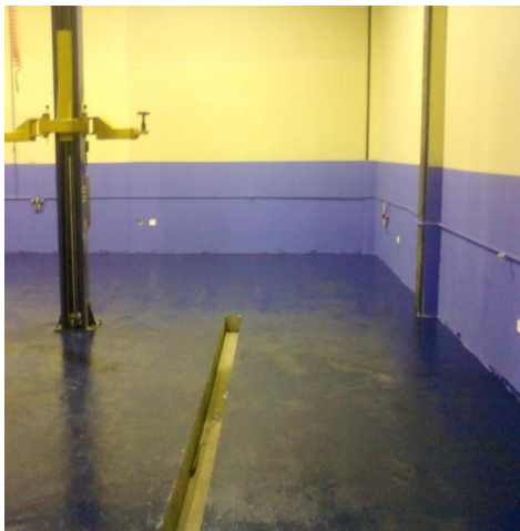
Fotografía N°28. Colocación de la pintura epoxica para piso
