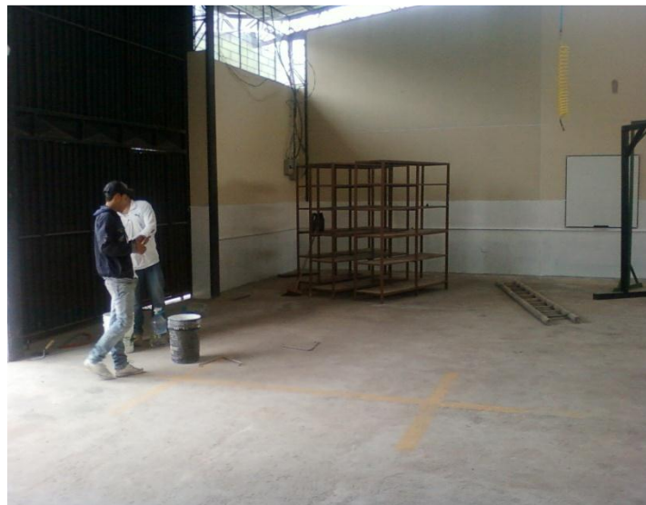
Fotografía N°21. Proceso de pintura en pared
