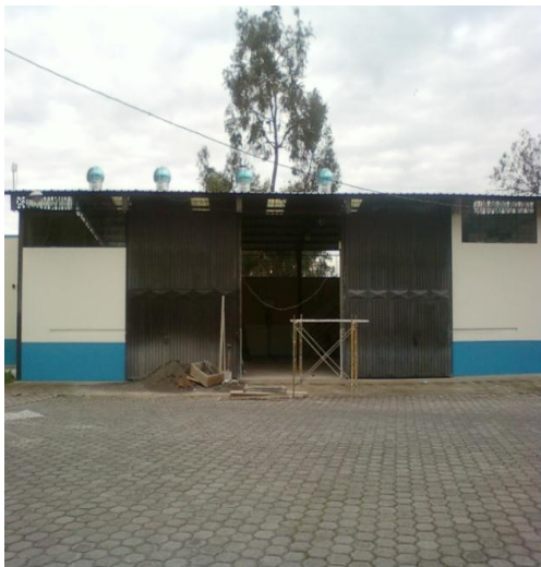
Fotografía N°17. Proceso de reubicación del portón
