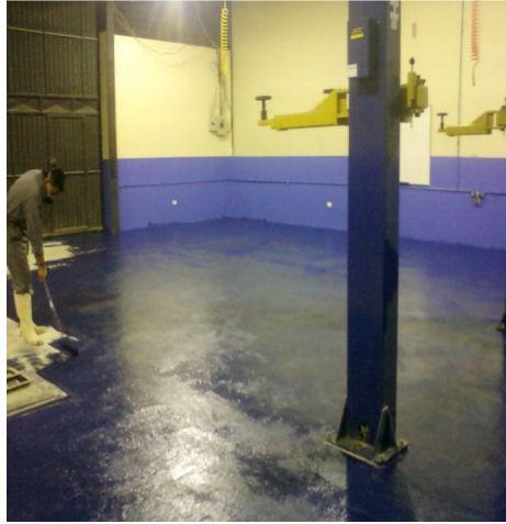
Fotografía N°26. Colocación de la pintura epoxica para piso
