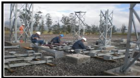
Figura 81. Preparación de seccionadores
