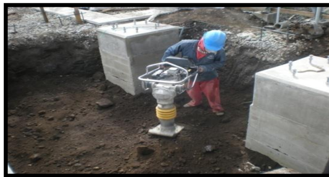
Figura 15. Compactación de suelos
