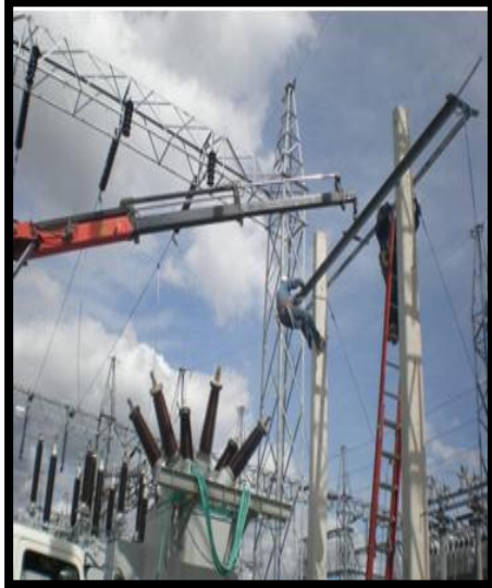
Figura 125. Montaje de postes con maquinaria
