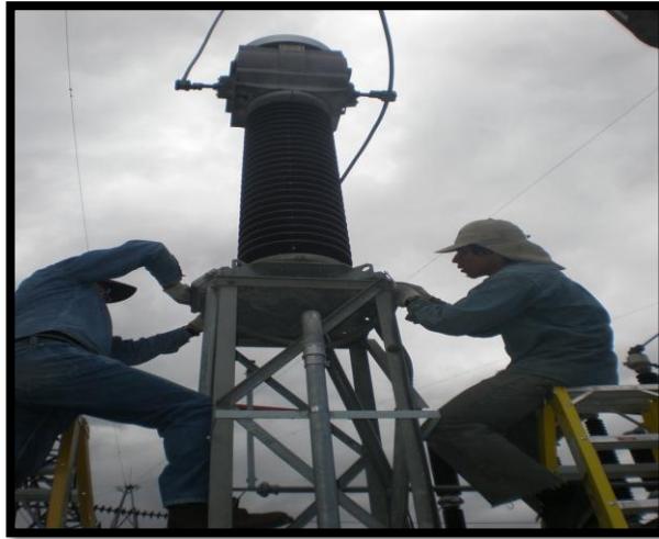
Figura 135. Colación de arandelas de presión en base de equipos
