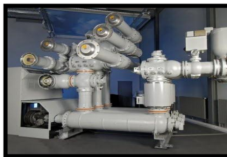
Figura 28. Subestación GIS encapsulada en subestación pequeña (vista lateral)
