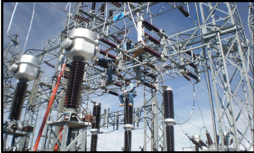
Figura 119. Montaje de disyuntor de potencia
