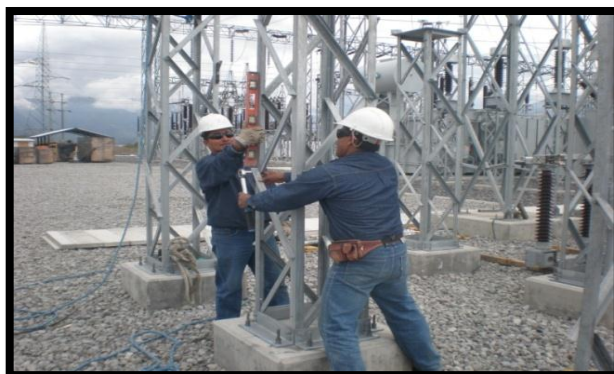
Figura 58. Ensamble de estructuras
