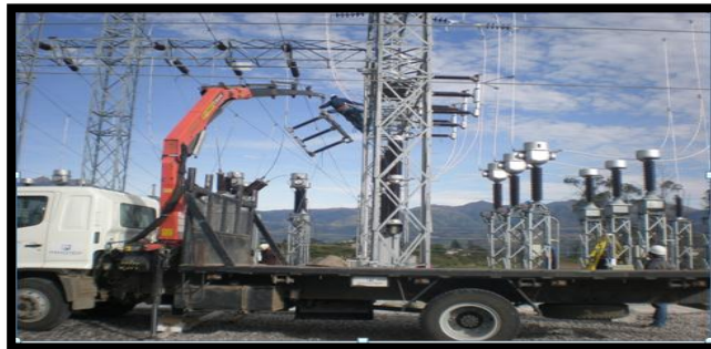
Figura 114. Uso de grúa para montaje de seccionadores
