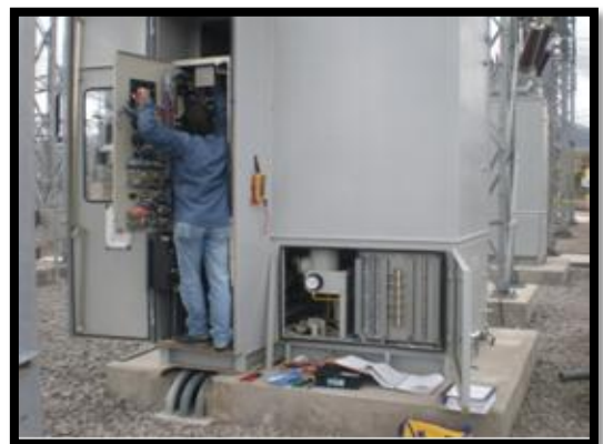
Figura 122. Ejecución de Conexiones en GIS
