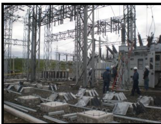
Figura 59. Empernado de estructuras
