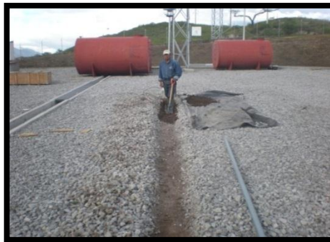
Figura 53. Zanjado para tuberías
