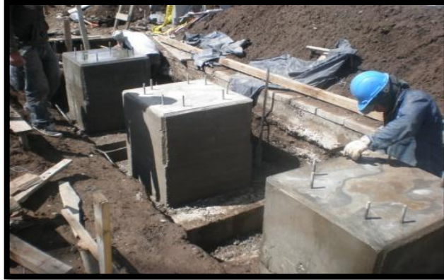
Figura 50. Retirado de encofrado
