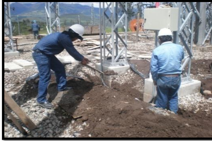
Figura 17. Colocación de suelos y grava
