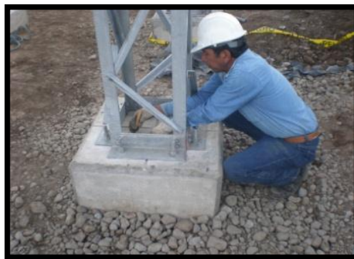
Figura 61. Cambio de bases a estructura
