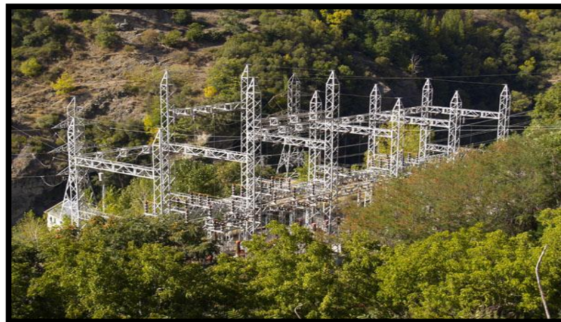
Figura 7. Subestación de Enlace
