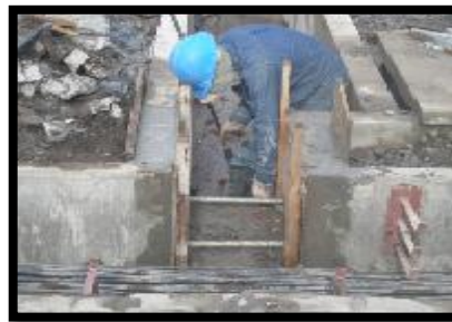
Figura 52. Zanjado para canaletas y tuberías
