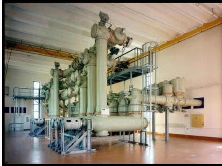
Figura 29. Subestación GIS encapsulada (vista lateral izquierda)
