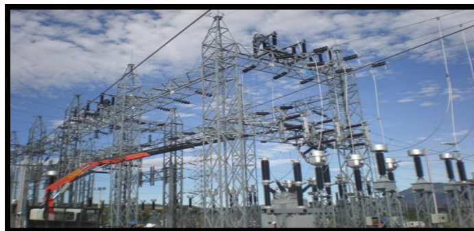
Figura 115. Trabajos con ayuda mecánica
