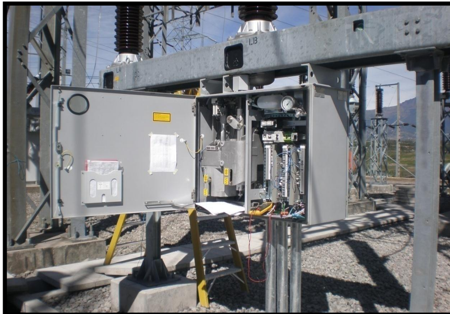
Figura 120. Revisión e Inspección del disyuntor
