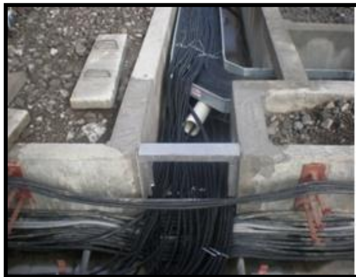
Figura 140. Cables de control y fuerza
