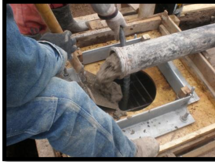
Figura 49. Relleno de hormigón
