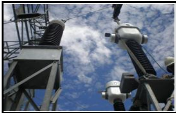
Figura 72. Ubicación de transformador de corriente
