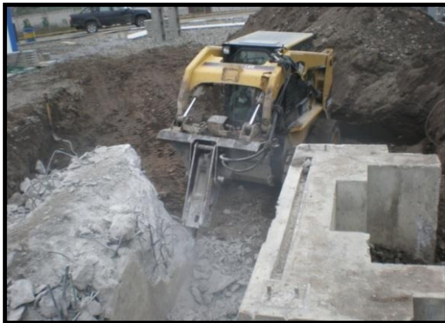
Figura 14. Trabajos de demolición
