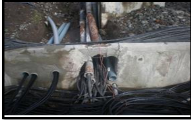
Figura 79. Tuberías de equipos de patio
