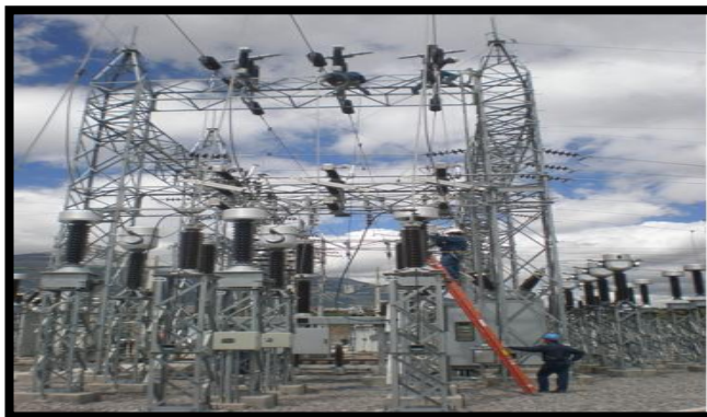
Figura 117. Trabajos de energización de bahías
