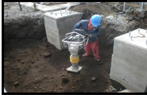
Figura 51. Compactación de suelo
