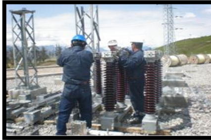
Figura 82. Nivelación de seccionadores
