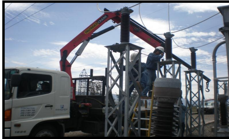
Figura 130. Montaje de pararrayos
