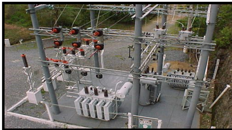
Figura 3. Subestación Elevadora pequeña vista aérea
