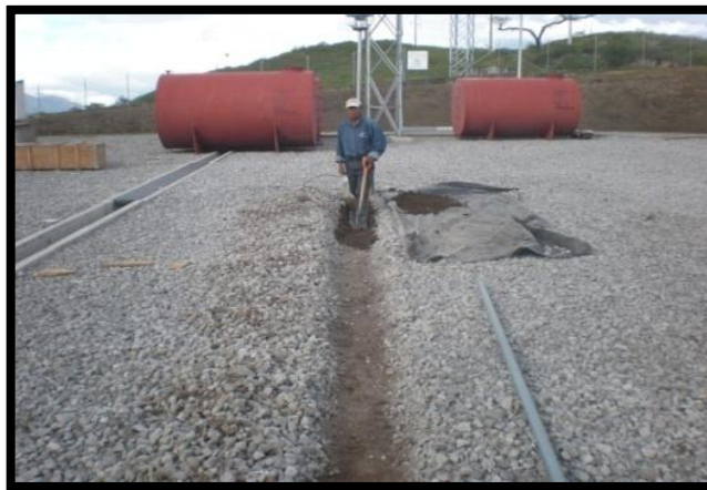
Figura 16. Colocación de grava
