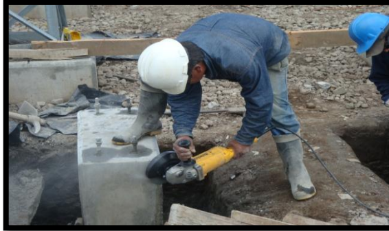
Figura 47. Adecuaciones a la cimentación
