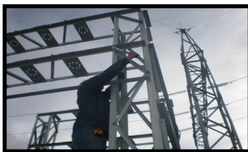
Figura 60. Torque a estructuras metálicas
