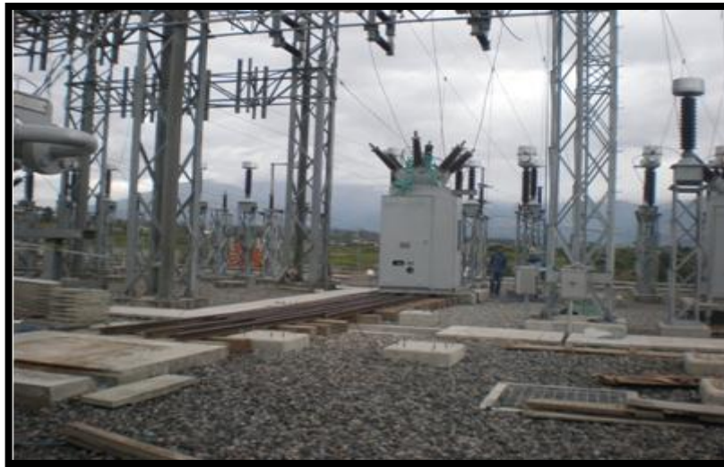
Figura 127. Deslizamiento de equipo GIS
