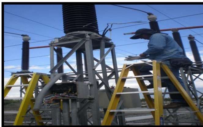
Figura 132. Montaje de base para pararrayos
