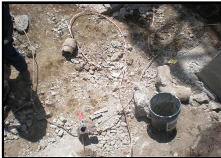
Figura 55. Preparación de materiales para suelda exotérmica
