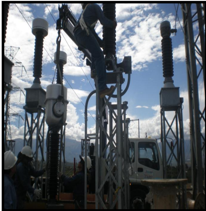
Figura 134. Camión grúa realizando montaje de equipos
