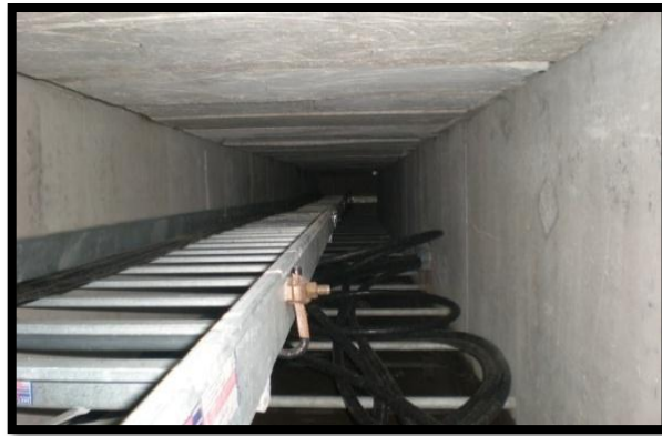
Figura 65. Conexión a tierra de bandeja porta cables
