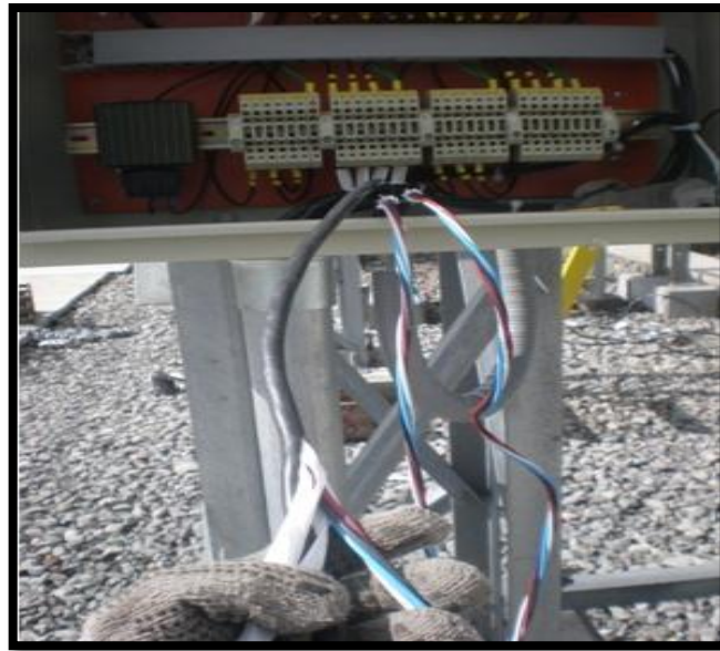
Figura 141. Preparación de cables
