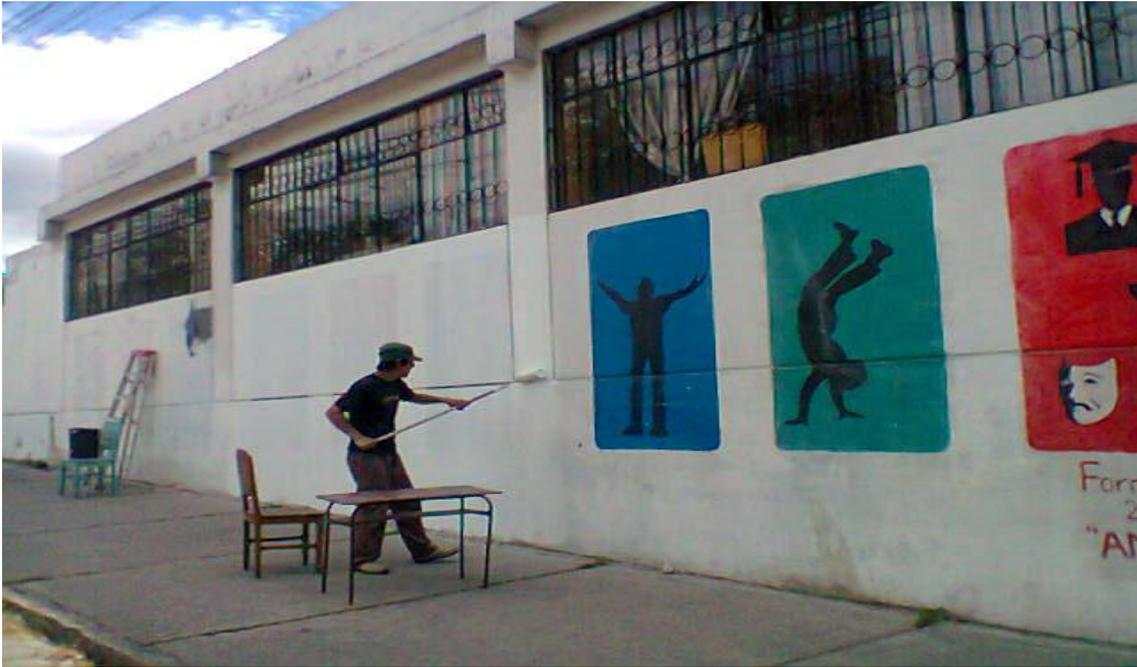
Posteriormente dar una capa de un impermeabilizador llamado agua stop, luego pintura blanca súper corona y resina con el fin de emporar y obtener un fondo adecuado para pintar.
