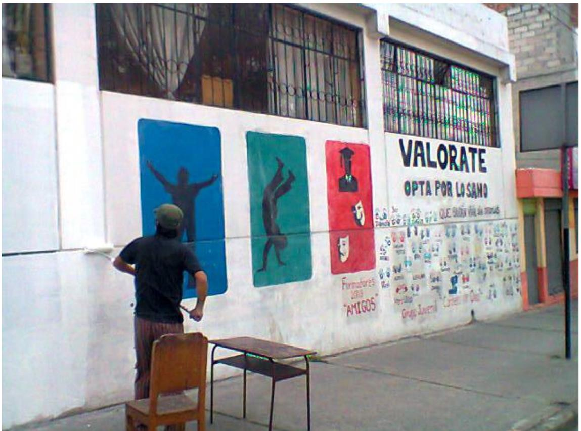
Preparación del espacio físico.- la pared debe estar libre de polvo y grasa o pintura es por eso que se requiere la limpieza total con una lija gruesa de pared que remueva toda impureza, luego se empora con una mezcla de yeso y resina para tapar los huecos.
