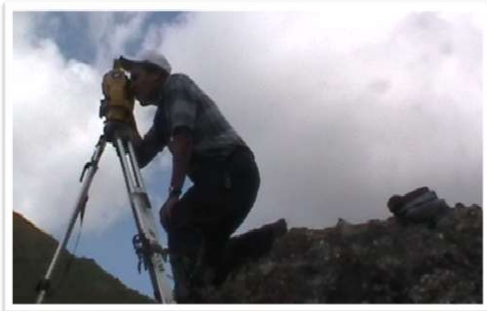
Parando la estación total y nivelando el eje horizontal.
