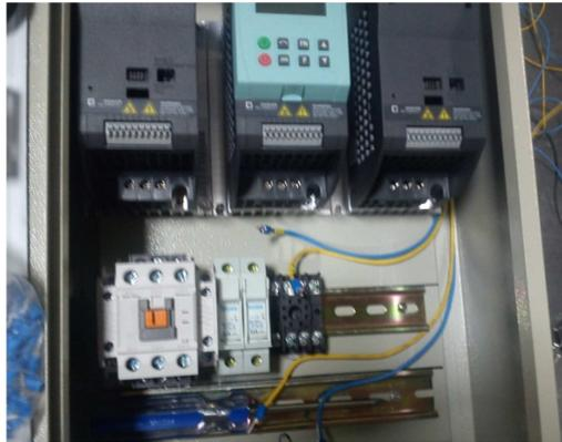
**Figura 6.42.** Montaje del tablero de control de los motores
