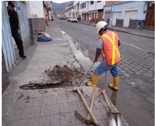
Fig.20-21 Áreas de trabajo sin señalización
