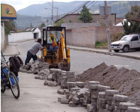
Fig.20-21 Áreas de trabajo sin señalización
