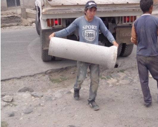
Fig.1 Sin ninguna precaución al momento de manipular cargas.
