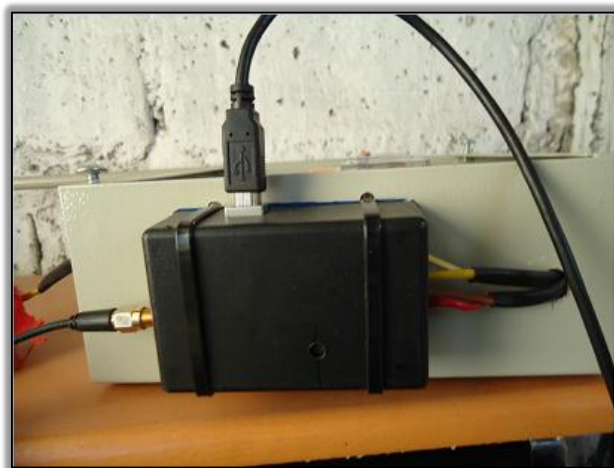
Figura 81. Instalación módulo central.
