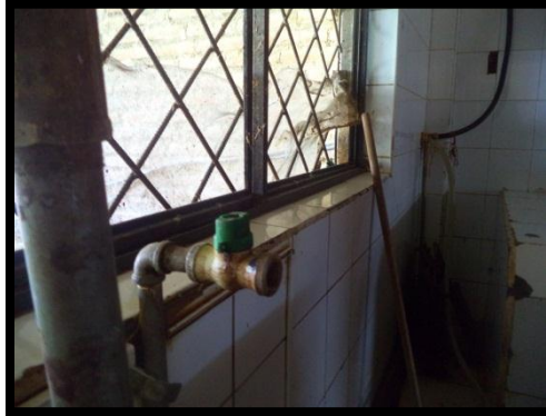
Figura 14. Válvula Ingreso de Agua
