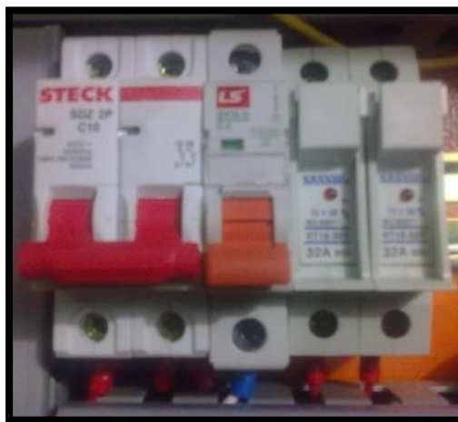
Figura 4. 9 Disyuntor y fusibles
