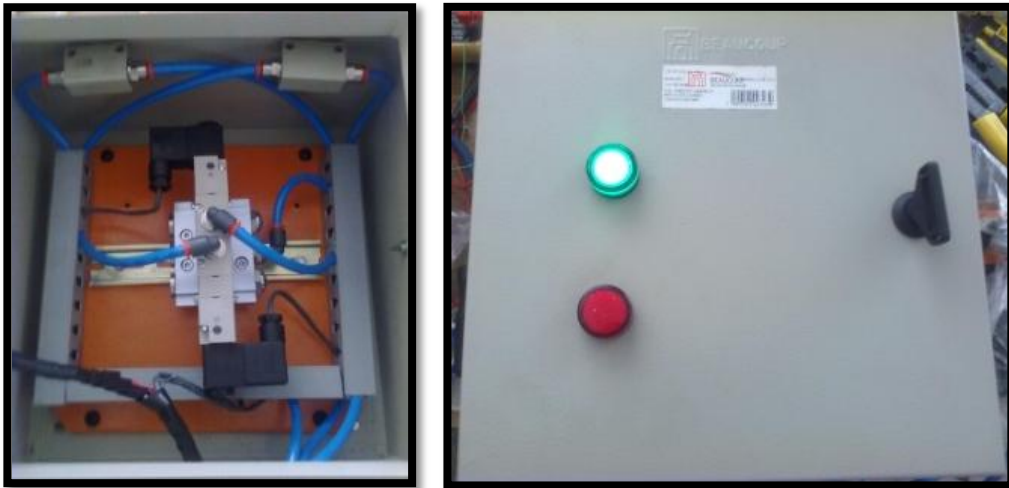
Figura 5. 5 Montaje Gabinete Neumático
