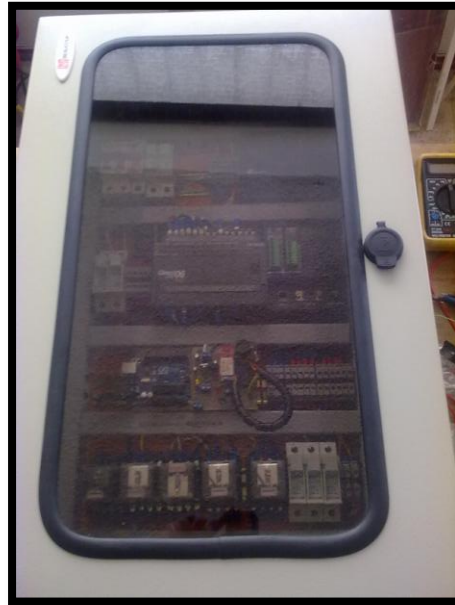
Figura 4. 17 Vista externa Gabinete de control
