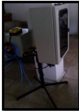
Figura 5. 2 Montaje Gabinetes sobre pedestal
