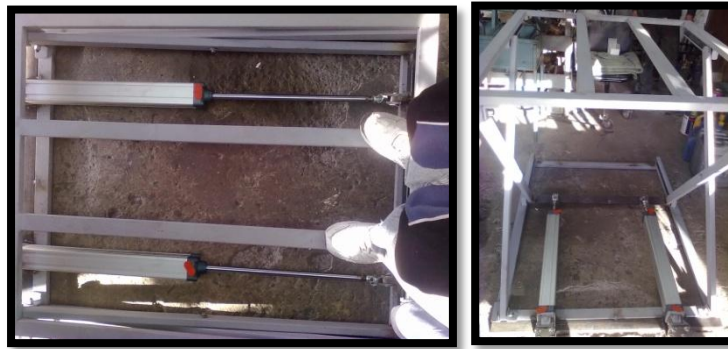
Figura 4. 4 Cilindros Neumáticos instalados
