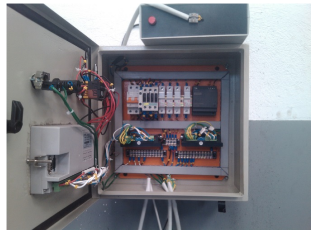
Figura 8 Tablero de control Fuente Autor.
