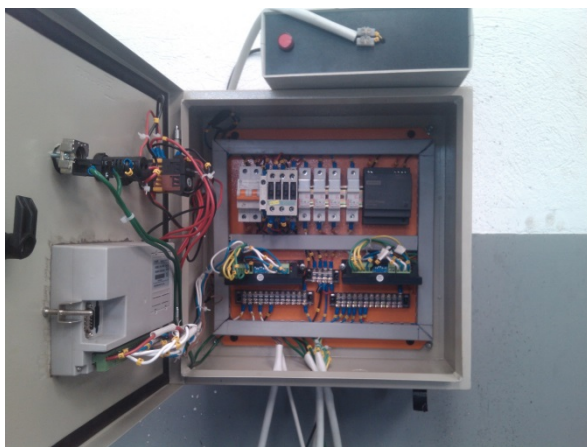
Figura 18 Tablero de control Fuente Autor.
