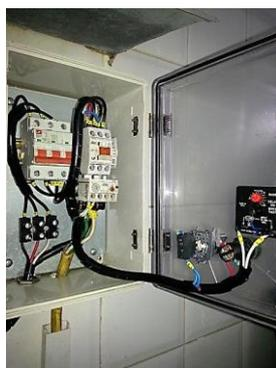
**Figura 21. Montaje del Tablero de Control de Nivel**
