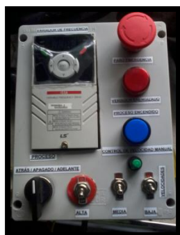
Figura 38. Caja térmica con sus respectivos controles.
