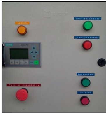
Figura 14. Colocación de los pulsadores y de las luces piloto en el tablero de control
