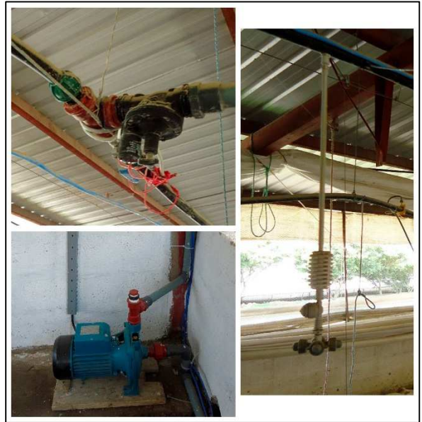
Figura 12.-Sistema de Nebulización
