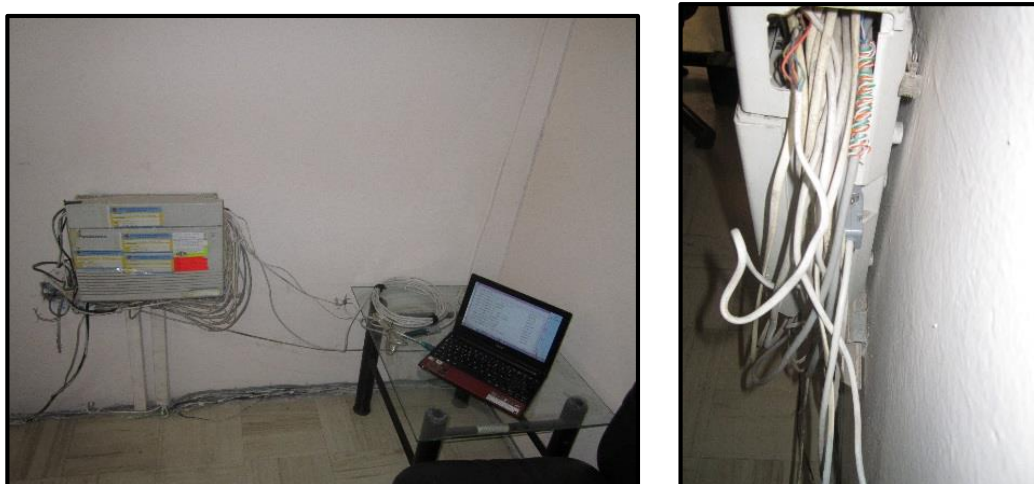
Figura 2.23. Conexión del PC a la central PANASONIC para monitoreo de llamadas Fotografía tomada por Pamela Godoy
