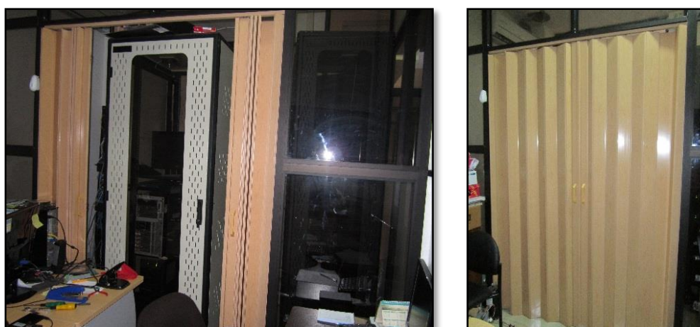
Figura 2.14. Cuarto de Comunicaciones del GADMU Fotografía tomada por Pamela Godoy
