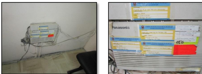
Figura 2.21. Central Telefónica Panasonic KX-TA616 con sus respectivas tarjetas. Fotografía tomada por Pamela Godoy
