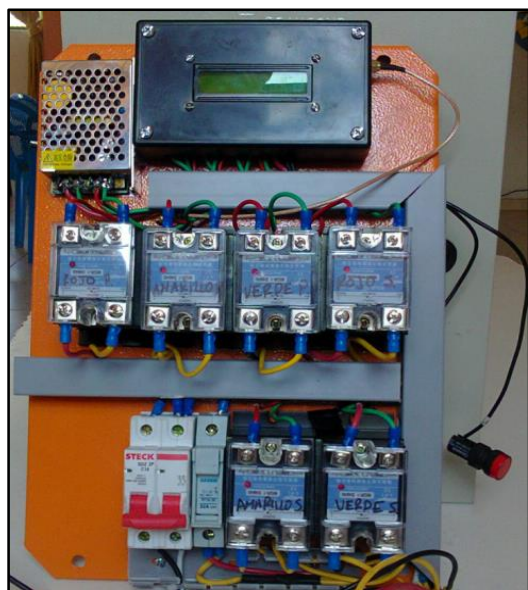
Figura 14. Montaje de los elementos en armario metálico
