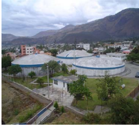
Fotografía° 3 Tanques de Recepción Agua Cruda
