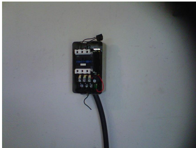
Figura 47: Arranque que permite encendido del compresor.
