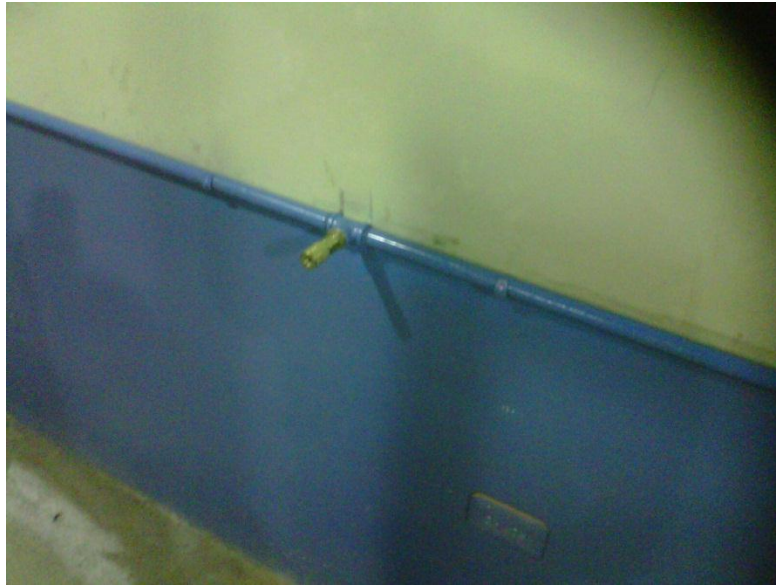
Figura 39: Toma de aire anclada a la pared ya pintada. Fuente: Bastidas M; Pinchao H. (2012)
