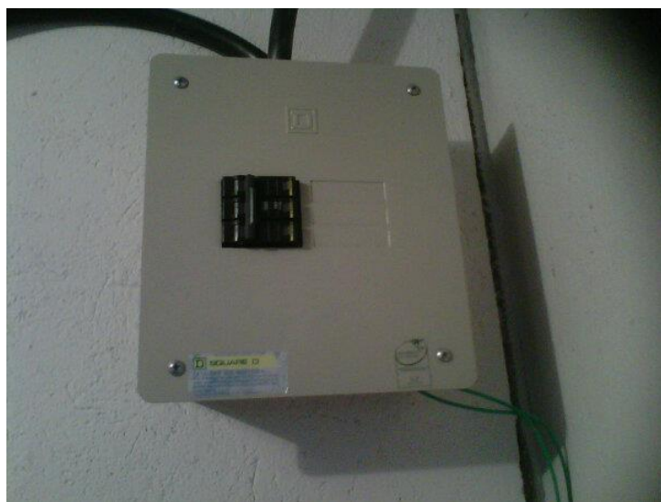
Figura 46: Caja trifásica.
