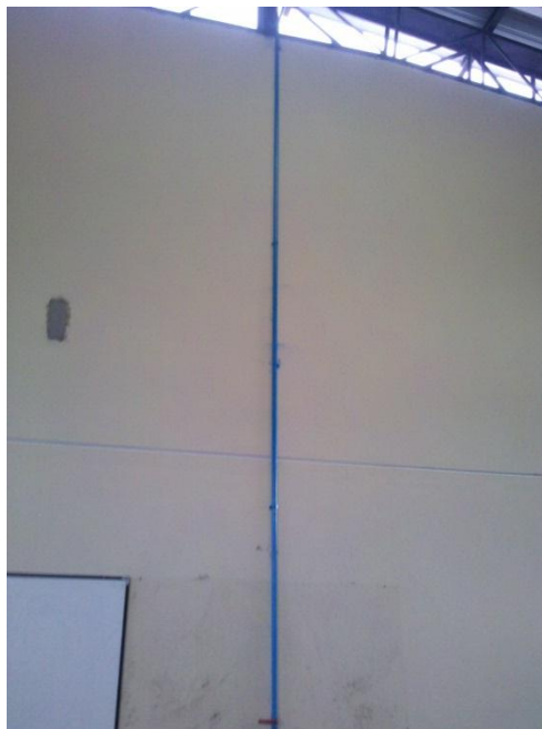
Figura 40: Tubería que lleva aire comprimido a la toma superior pintada de azul moderado. Fuente: Bastidas M; Pinchao H. (2012)
