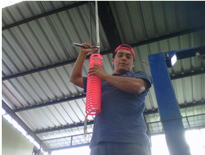
Figura 38: Montaje de tomas aéreas espirales.
