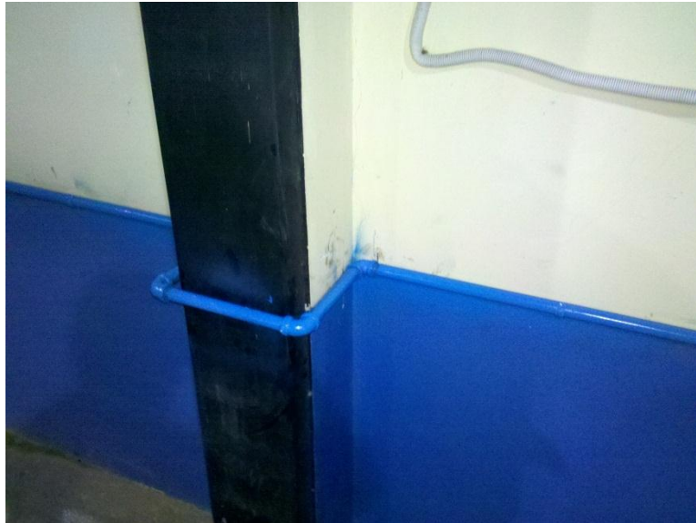
Figura 41: Tramo de tubería pintada de azul moderado.
