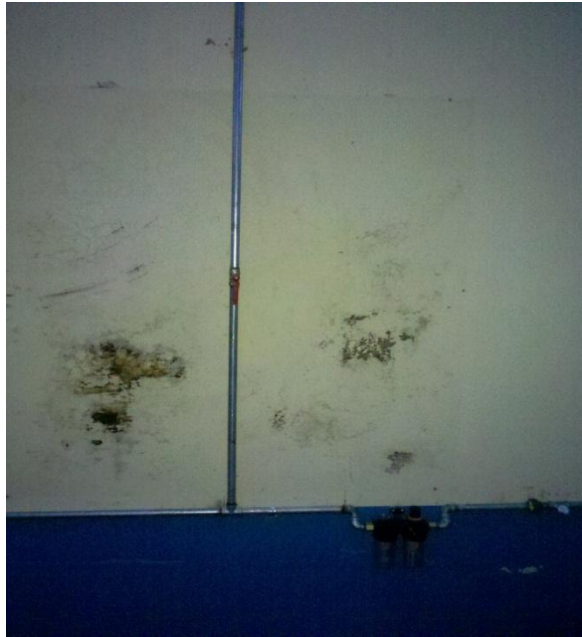
Figura 35: Tubería que conduce aire hacia la toma aérea. Fuente: Bastidas M; Pinchao H. (2012)
