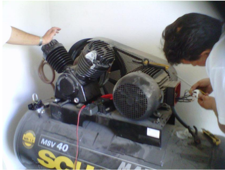
Figura 48: Conexión de fases del motor eléctrico de 10 HP.
