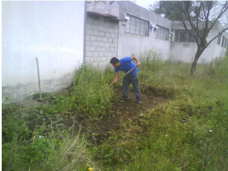
Figura 42: Preparando área de construcción del cuarto de compresores.
