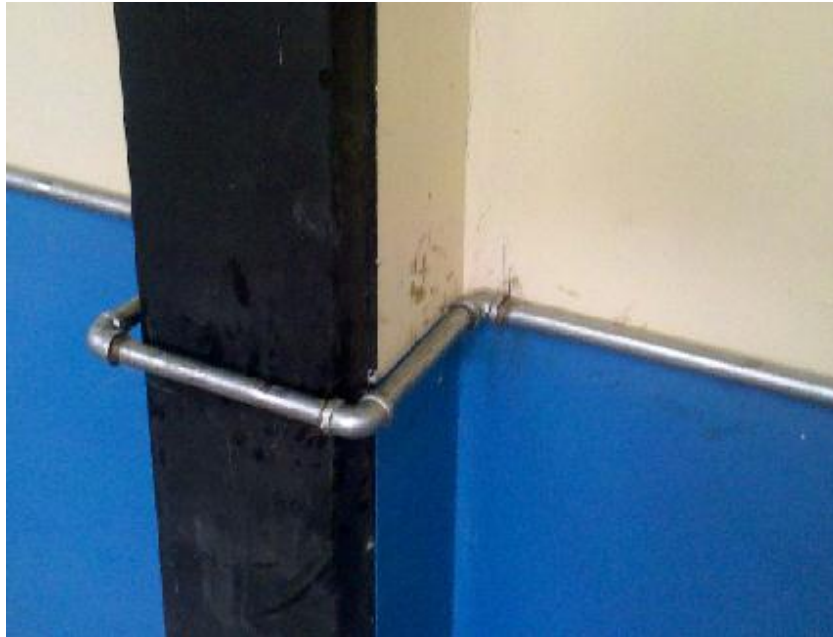
Figura 32: Paso de tubería sobre una columna. Fuente: Bastidas M; Pinchao H. (2012)
