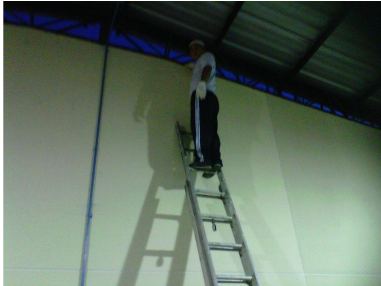
Figura 45: Tendido de cable a través de la estructura del taller.
