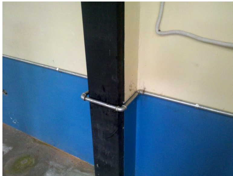
Figura 30: Sección de tubería instalada.
