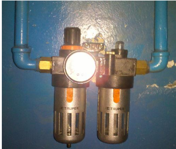
Figura 29: Primera unidad de mantenimiento.
