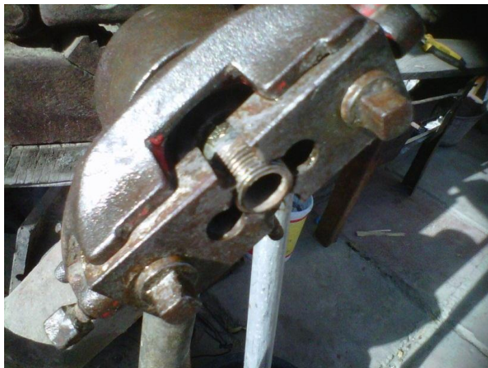
Figura 27: Realizando roscado de tubería. Fuente. Bastidas M; Pinchao H. (2012)
