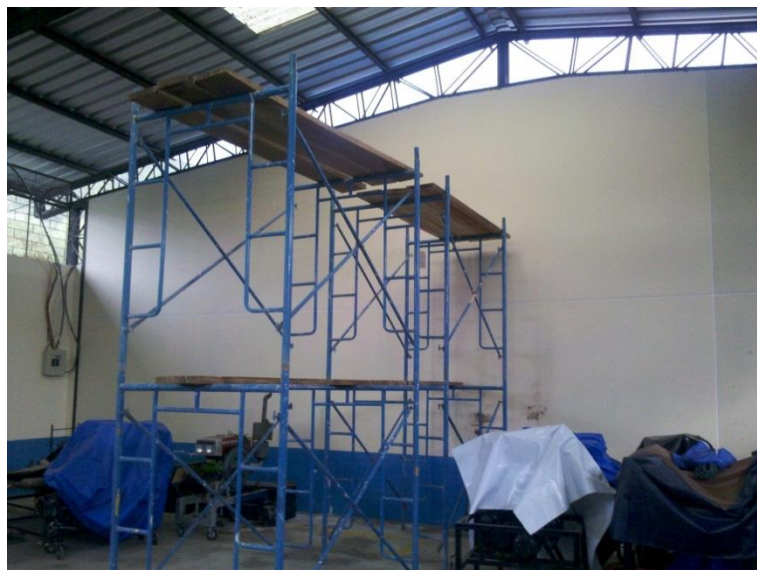
Figura 36: Estructura metálica. Fuente: Bastidas M; Pinchao H. (2012)
