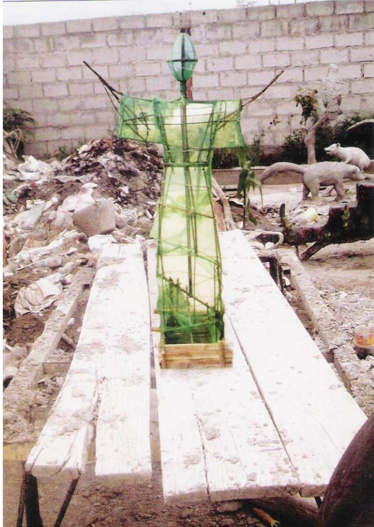
Estructura o esqueleto que servirla de base, diseñado en varilla N° 8, 10,12 y 1/4
