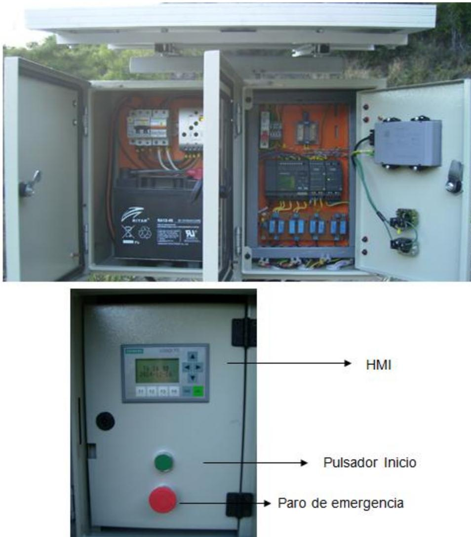
**Figura 4.18** *Instalación completa y partes del panel frontal*
