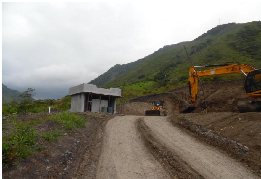
Figura 30: Estado de avance de construcción del proyecto. 2015
