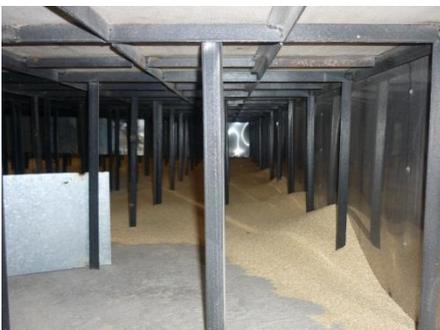
**Figura 60** Desperdicio generado por aberturas en la plancha de secado
