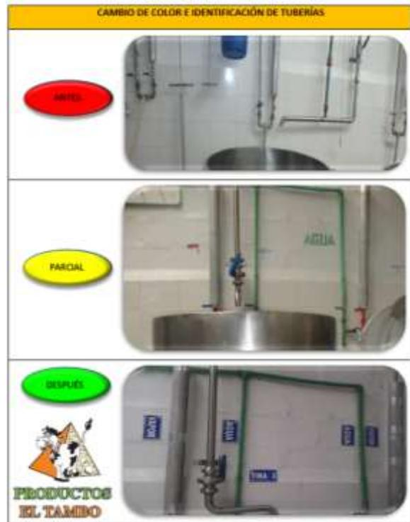
Figura. 6. Cambio de color e identificación de tuberías
