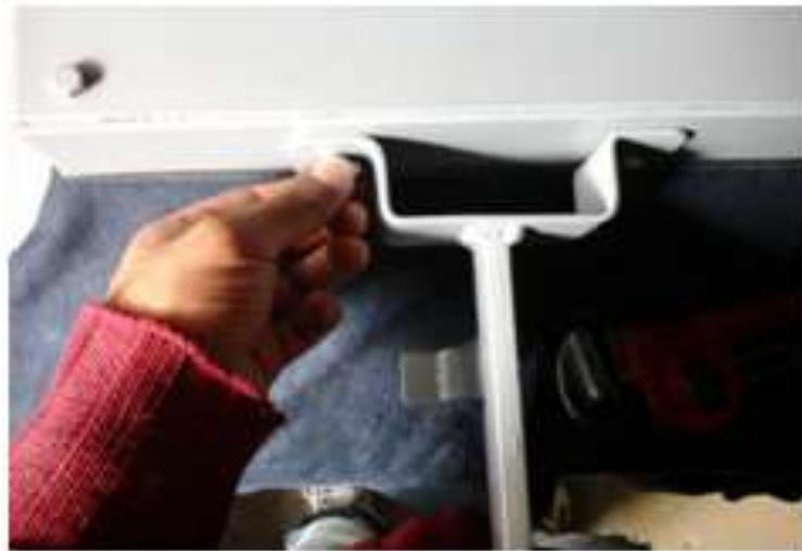
Fig. 3.10 Instalación del soporte de la cerradura electromagnética
