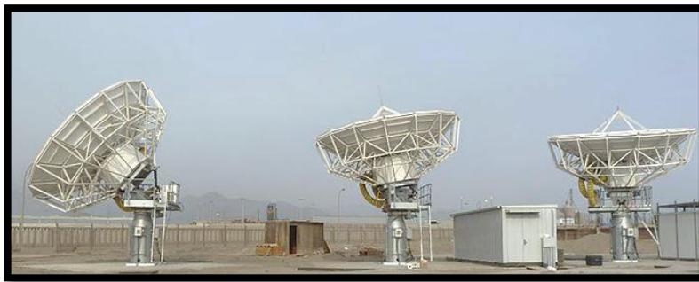
Figura 24.- Estación terrena de Lurín- Lima-Perú.
