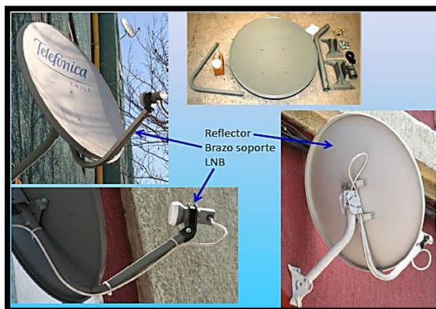
Figura 7.- Componentes de la instalación de la antena parabólica.
