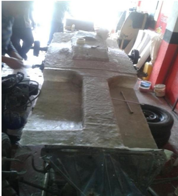
**Figura 65. Vista frontal proceso de curado del piso finalizado.**
