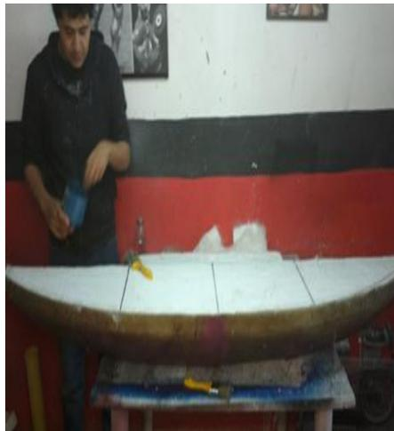
**Figura 87. Laminación del parachoques.**
