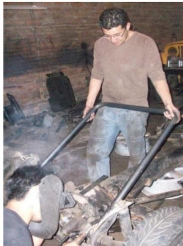
**Figura 55. Soldado de la estructura frontal del chasis.**
