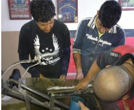
**Figura 80. Sujeción de moldes laterales al chasis.**
