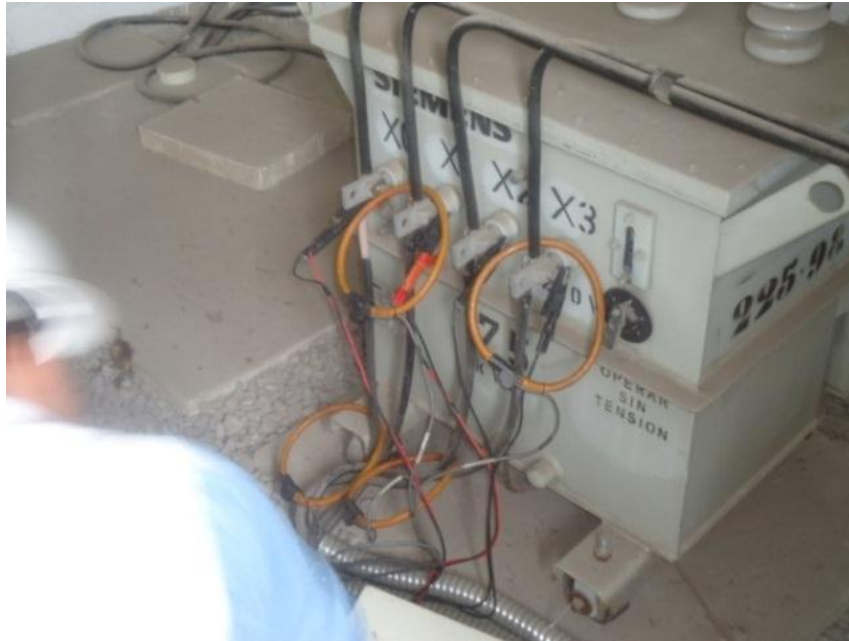
Gráfico 18 Conexión en transformador de 75 kVA
