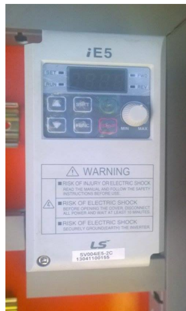
Figura 27. Variador de frecuencia.
