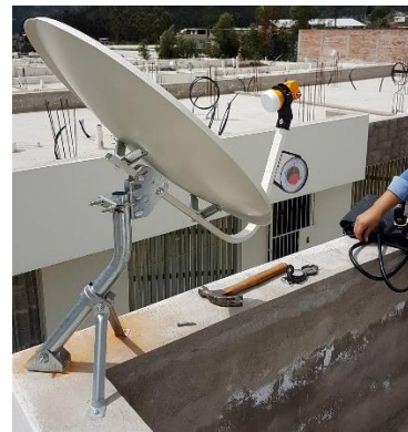
Fig 10. Ensamblaje y fijación de la antena
