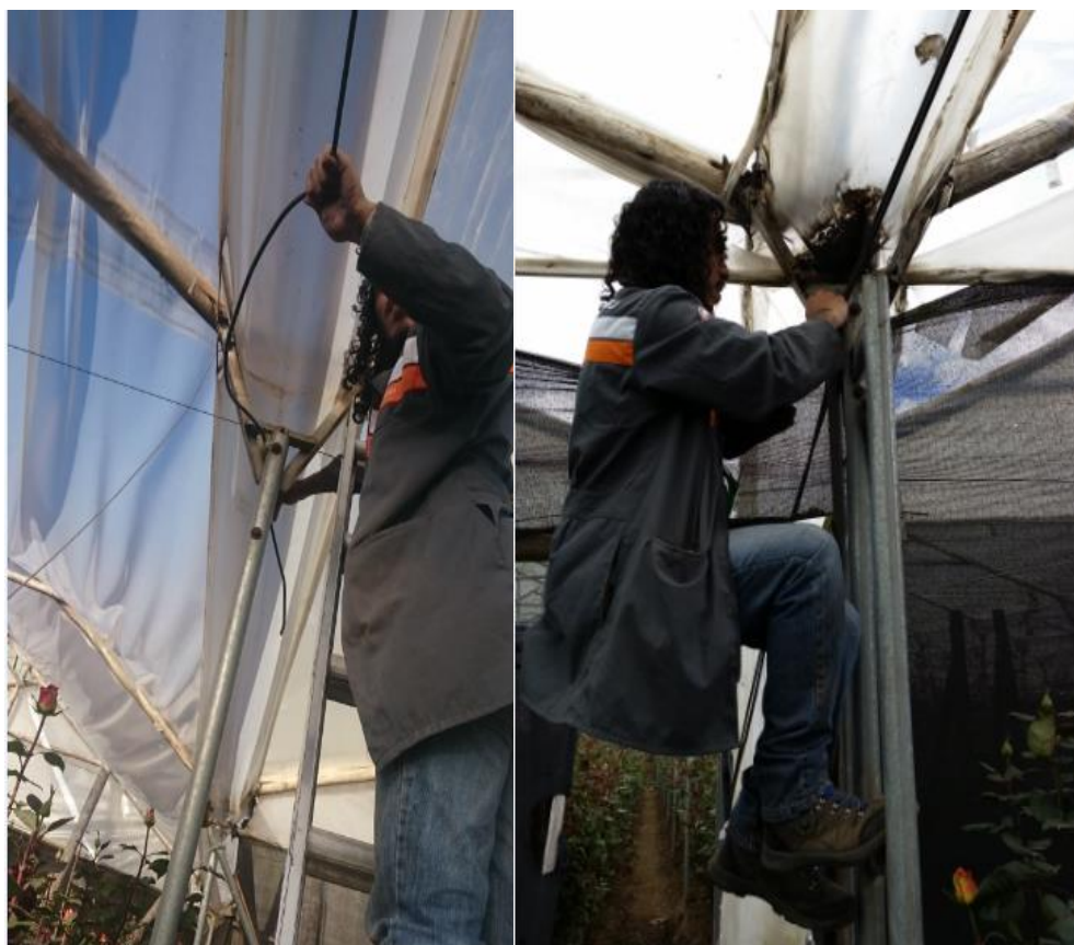
Figura 65: "Izquierda" Estirando el cable por lo postes del invernadero Figura 66: "Derecha" Asegurando el cable
