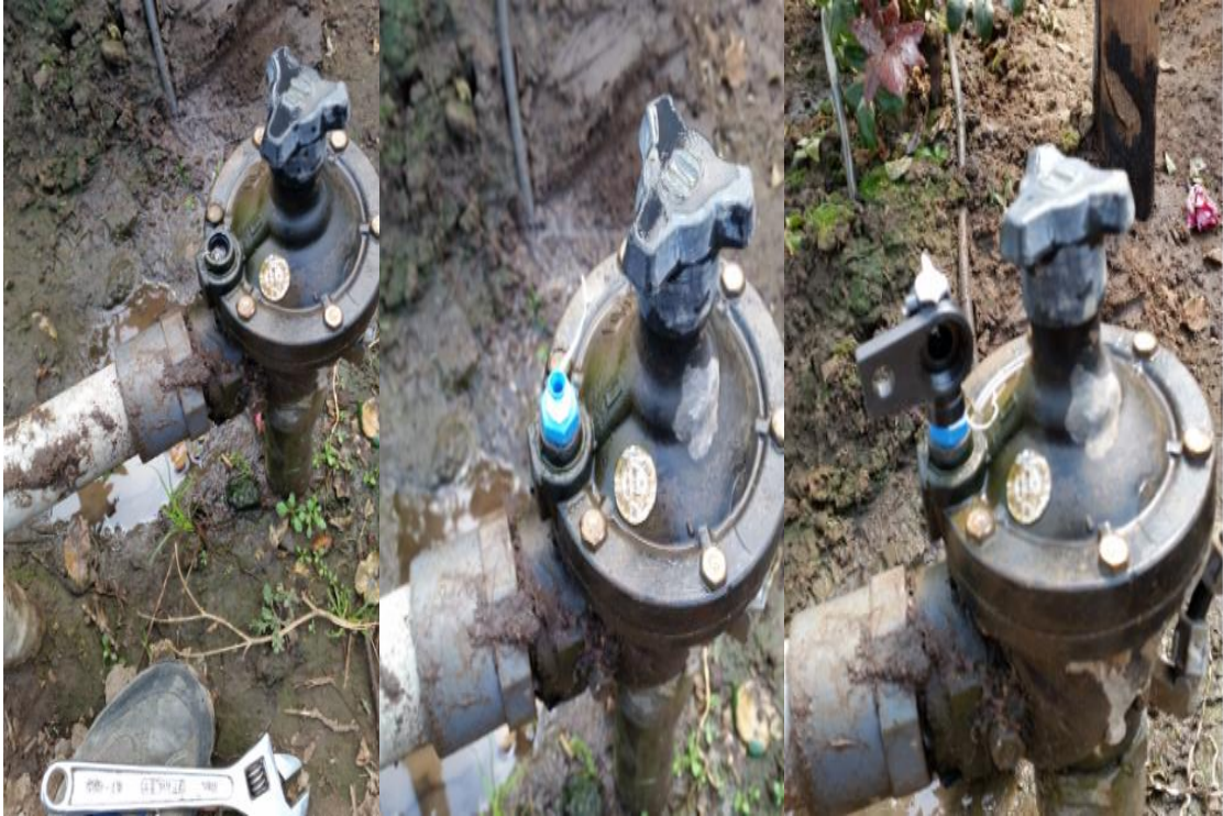
Figura 70: Accionamiento manual retirado y colocando la base del solenoide.
