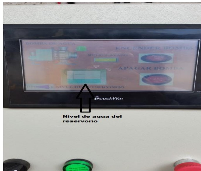
Figura 79: Nivel de agua en el reservorio
