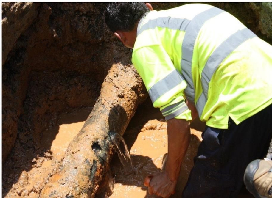
*Figura 30. Forma de ruptura de la tubería de agua potable por la presión de agua ejercida*
