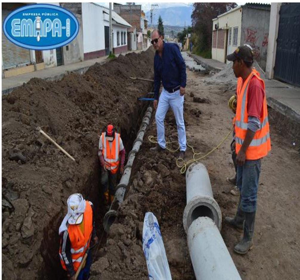
*Figura 24. Instalación de tubería de abastecimiento de agua potable
