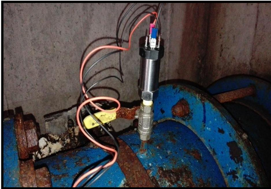
*Figura 73. Conexión del sensor de presión en la tubería principal de agua potable*
