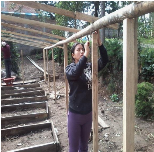
Instalación del vivero
