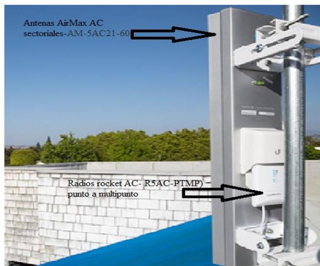
Figura 36. Conexión de una antena sectorial y Radio
