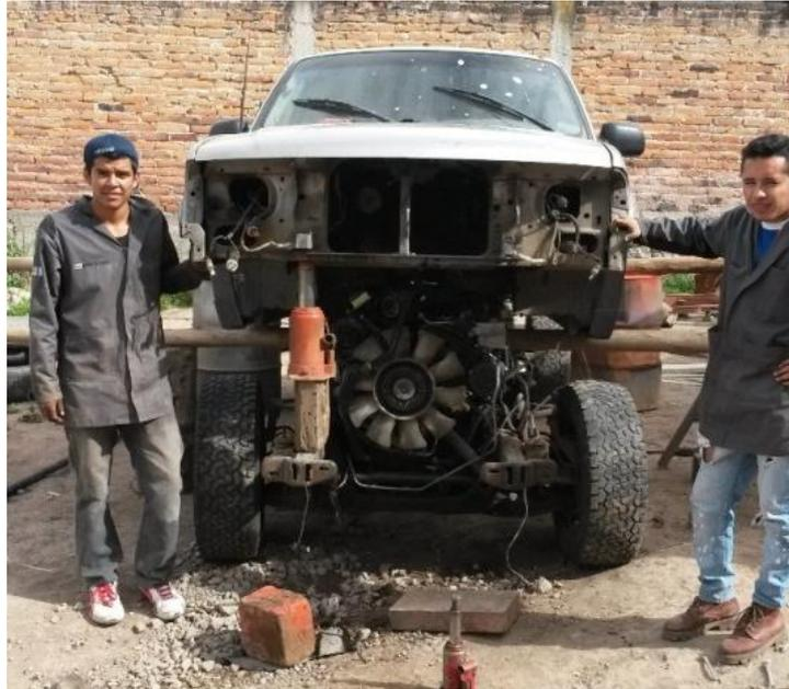
**FIGURA 23:** Desmontaje de la carrocería.
