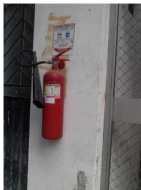
Figura 26. Localización del extintor de incendios
