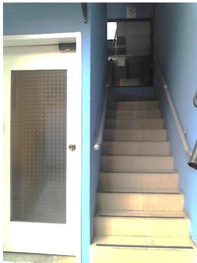
Figura 21. Gradas y ventanas que se encuentran en el área de recursos informáticos
