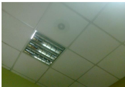
Figura 20. Techo falso colocado en el área de recursos humanos
