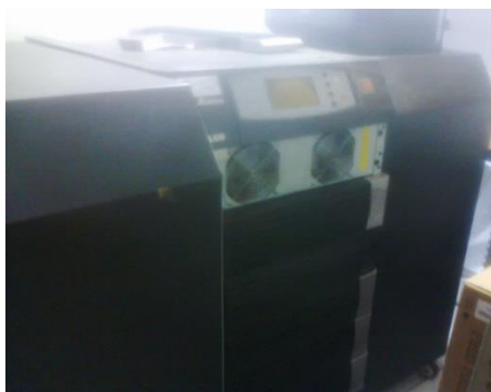
Figura 24. UPS Delta Power de la empresa localizada en el área de recursos informáticos
