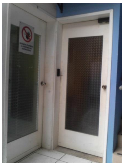
Figura 19. Puertas de acceso al área del cuarto de equipos
