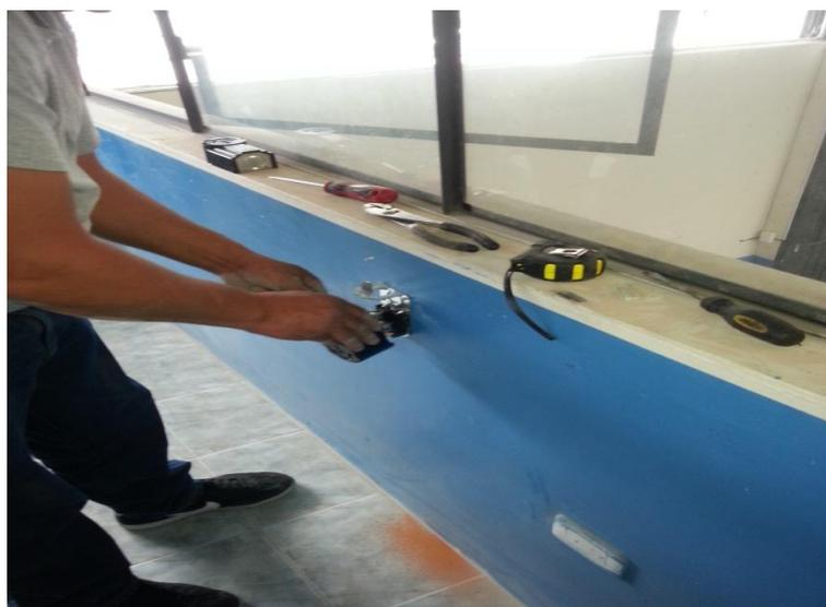
Figura 9: Instalación de tomacorrientes.
