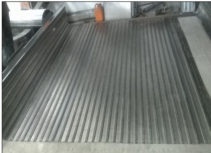
Ilustración 23: Armado e Instalación.
