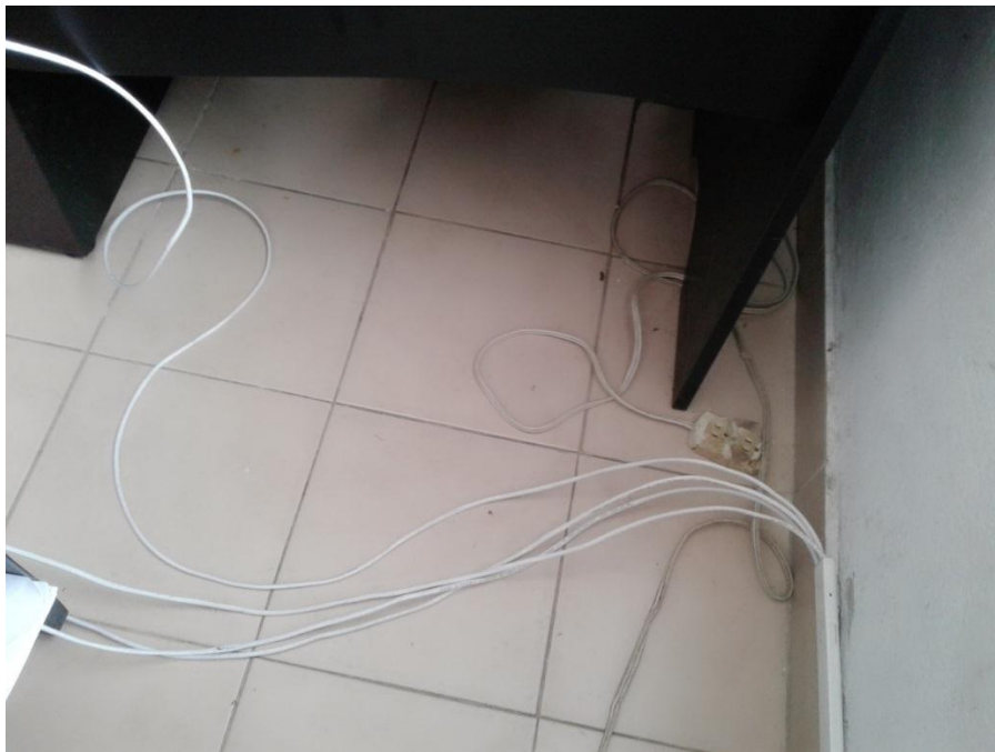
Cables en el suelo
