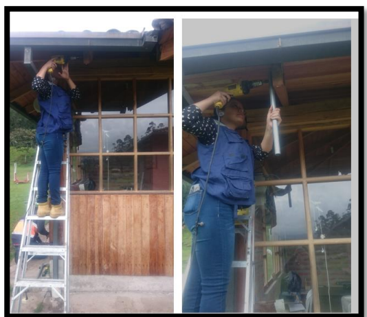
Figura 6. Implementación Soporte para Antena Litebeam M5-23, Bosque Protector. Fuente: Implementación de equipos.
