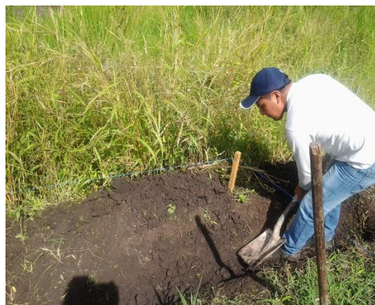
Fotografía 12. Limpieza de Camellones Fuente: El Autor, 2014
