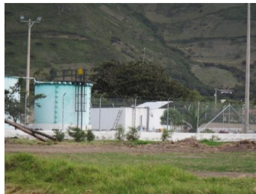
Figura 3.4. Planta de Tratamiento del Lago de Yahuarcocha
