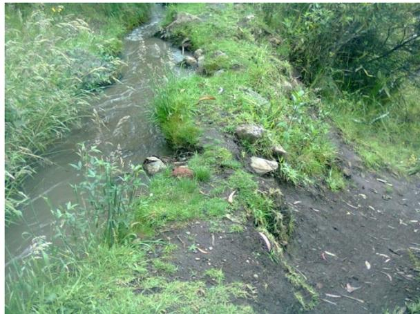
**Figura 16;** Déficit infraestructural de la acequia, se observa la precariedad de la infraestructura de la acequia, en esta sección la acequia ha sido recuperada por los mismos comuneros y se pudo ver las medidas emergentes que los usuarios realizan para recuperar el canal de la acequia. Piedras, ramas y tierra son los recursos con los cuales los comuneros realizan estas reparaciones, lo cual causa que este canal colapse regularmente.
