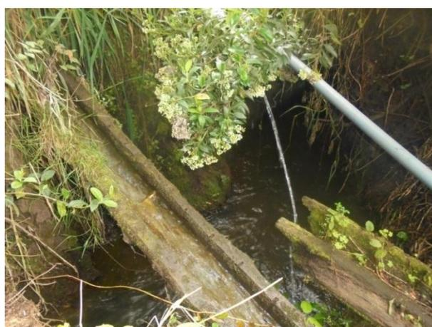
**Figura 12;** Afluente de aguas servidas vertidas en el sistema de riego en el sector de la comunidad de la Esperanza, se observa también la precariedad del sistema de riego y las condiciones infraestructurales actuales que permiten que el agua sea contaminada por estos afluentes.
