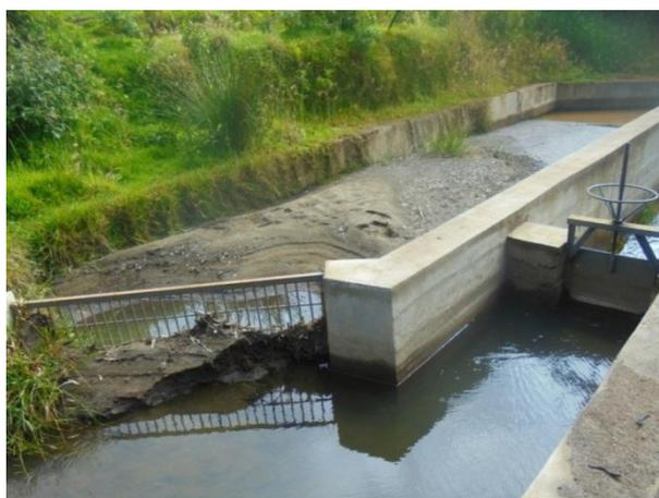
**Figura 8;** Captación acequia en el río Bobo, se observa la acumulación de sedimento en la captación lo cual obstruye el ingreso del agua al canal principal, no existe ninguna obra que proteja esta infraestructura esto hace que el deterioro de la misma sea más progresiva.
