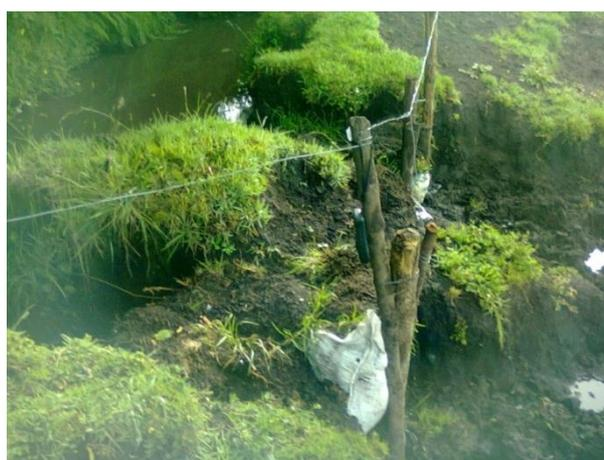
**Figura 10;** Estado actual acequia el Tambo, se observa el deterioro del canal principal de la acequia debido a la presencia de la ganadería de esta zona, se puede ver las obras emergentes que los comuneros realizan para mitigar este problema debido a la falta de recursos económicos.
