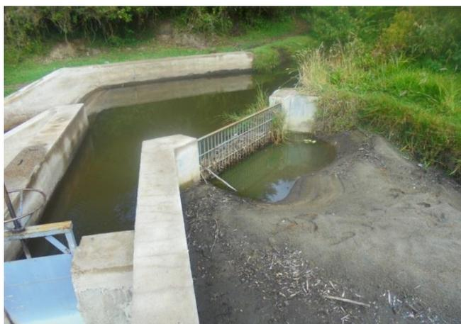
**Figura 2;** Captación de la acequia El Tambo, se identifica las pésimas condiciones estructurales de la captación debido a la falencia de requerimientos técnicos para la implementación de la misma, se evidencia que no existe ninguna obra que proteja esta infraestructura.
