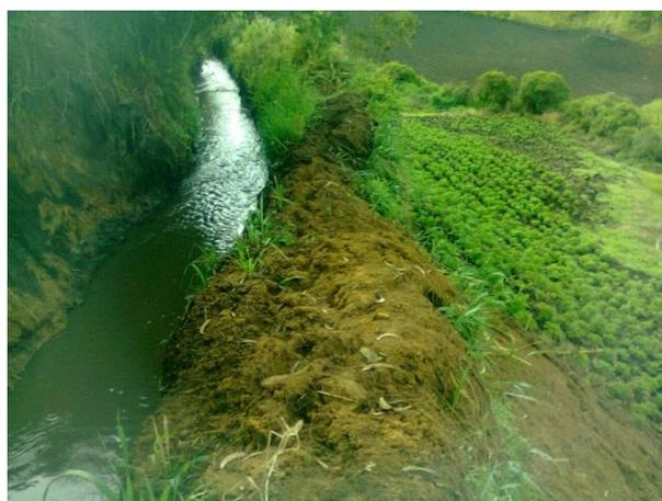
**Figura 19;** Inestabilidad del canal principal de la acequia, amenaza a cultivos cercanos, algunos agricultores no respetan la restricción hídrica y el riesgo del colapso del sistema es grande, como se puede ver en esta figura.
