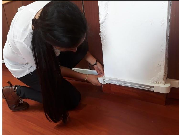
Se cubrió con los cajetines cada punto doble y simple de red. Conectando adicionalmente el patch cord de longitud 3 metros.
