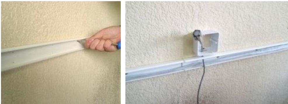
*Figura 65.* Enrutamiento con canaleta plástica. Red de datos de la Cámara de Comercio de Otavalo.
