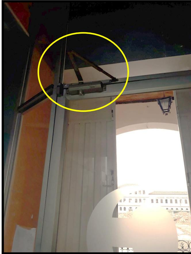
*Figura 70.* Pivote electromagnético instalado en la puerta de entrada del edificio. Control biométrico de la Cámara de Comercio de Otavalo.
