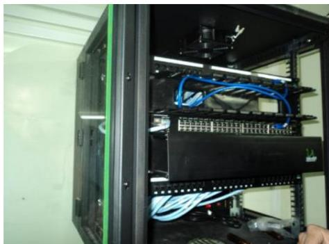
*Figura 66.* Rack de pared planta baja. Red de datos de la Cámara de Comercio de Otavalo.
