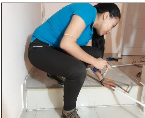
Una vez canalizados todos los pares trenzados se procedió a colocar la cubierta de las canaletas conjuntamente con los ángulos externos e internos.
