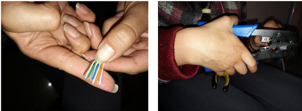
*Figura 59.* Ponchado de cable UTP con conector RJ-45. Red de datos de la Cámara de Comercio de Otavalo.
