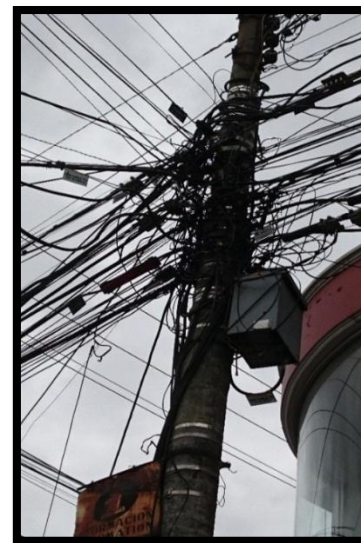
Figura 4 Saturación de Cables en poste de la Avenida Alfredo Pérez Guerrero y Simón Bolívar
