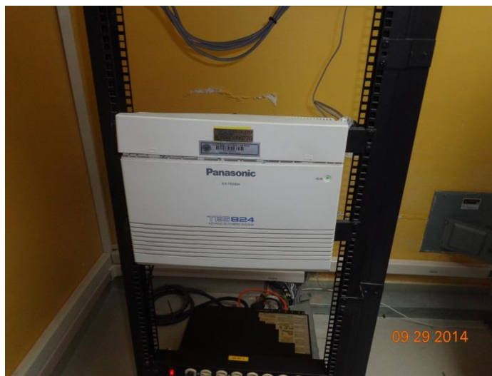
Figura 10. Rack de servidores
