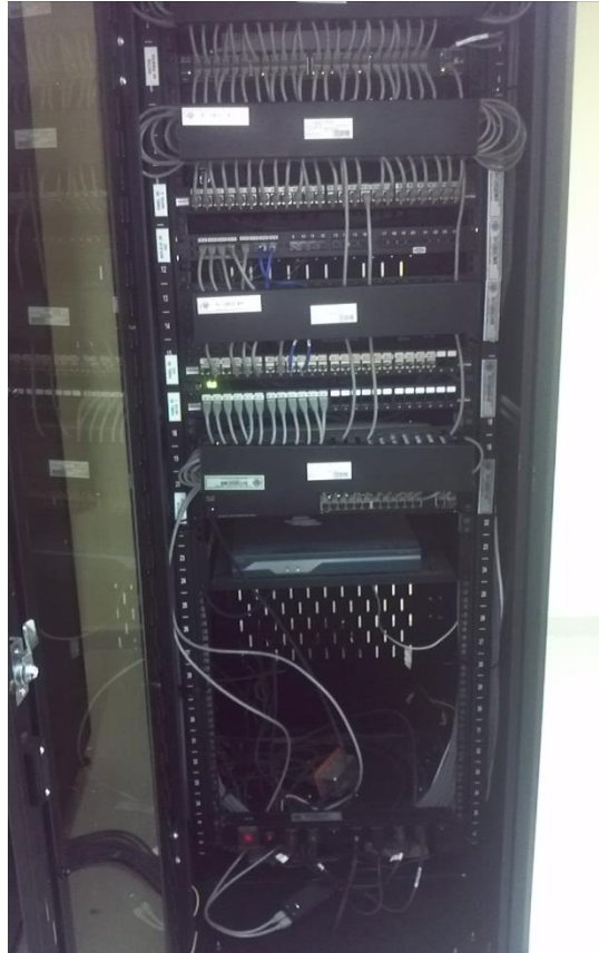
Figura 12. Rack de equipos de comunicación Fuente. Fotografiado por Verónica Collahuazo, cuarto de equipos
