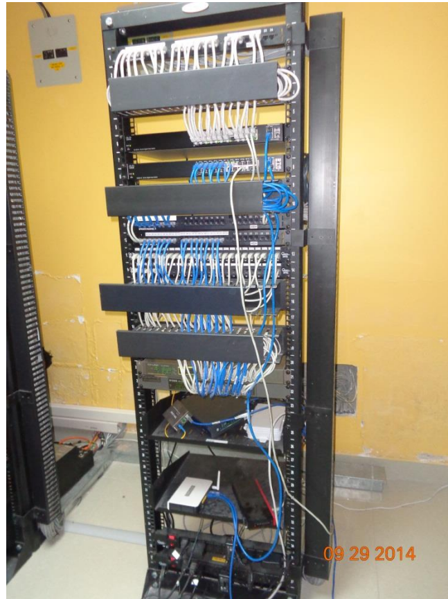
Figura 5 Rack de acceso
