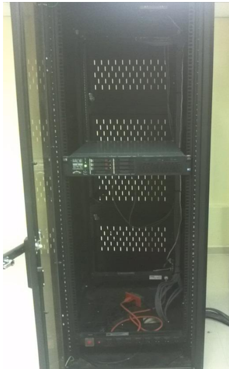
Figura 11. Rack de servidores
