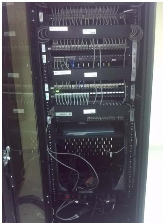
Figura 14. Rack de equipos de comunicación Fuente: Fotografiado por Verónica Collahuazo, cuarto de equipos
