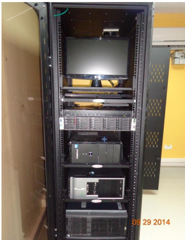
Figura 6. Rack de servidores
