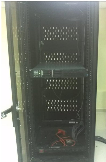
Figura 13 rack de servidores de la sucursal Atuntaqui Fuente. Fotografiado por Verónica Collahuazo, cuarto de equipos
