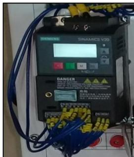
*Figura 46:* Variador de velocidad Sinamics V20.
